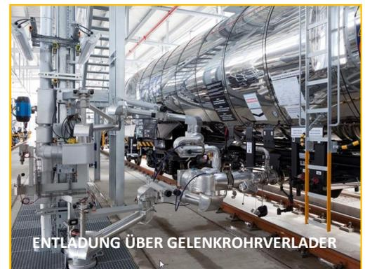
ENTLADUNG ÜBER GELENKROHRVERLADER
