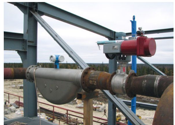
Bild 5. Einbau des Coriolis-Massemessgerätes Promass F bei der Errichtung der Anlage (Abstimmung nur während der Montage).
