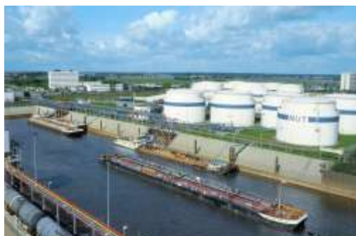
Tanklager und deren Nebenanlagen
